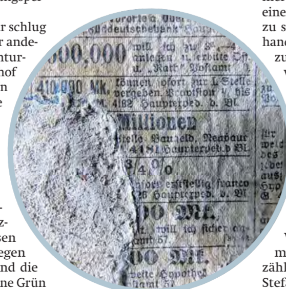
Entblättert: Es hat seine Vorteile, dass früher immer Zeitungen als Tapetenunterlage verwendet wurden. Man kann noch heute nachvollziehen, wann tapeziert wurde.
