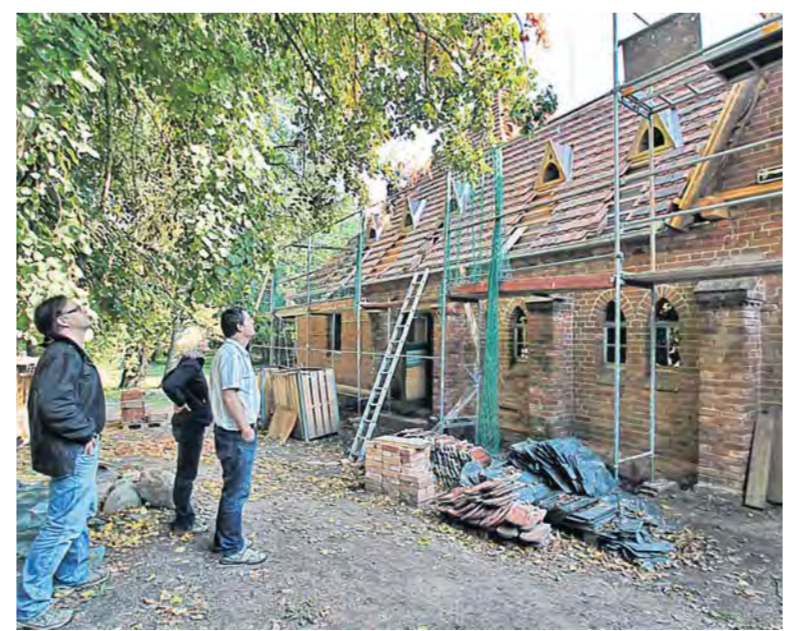
Matthias Hartig (links) von der gleichnamigen Zimmererei sowie Dorothea und Stefan Gesell vom beauftragten Architekturbüro begutachten die neue alte Ansicht des hinteren Gebäudeflügels.
