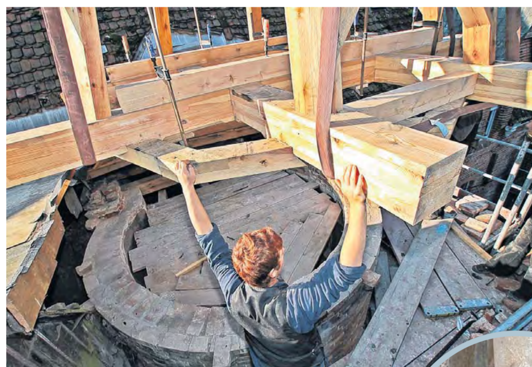
• Links Heute ein Kaiser: Das einzige, was vom alten Dachstuhl des Treppenturms noch zu retten war, war der sogenannte Kaiserstiel - eine ausgefellte Konstruktion, die für optimalen Zusammenhalt der Dachsparren sorgt.
