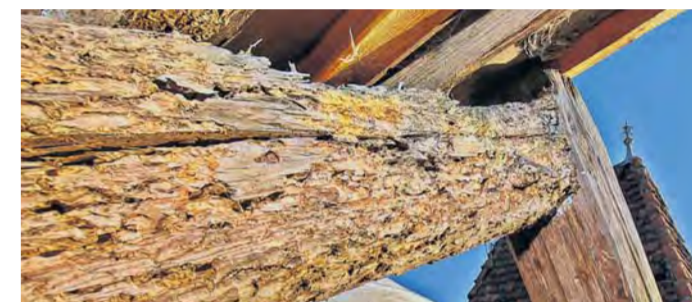
Mürbe, marode, malade: Das Holz in den Balkenkonstruktionen des Gutshauses präsentierte sich in vielfältigen Formen des Zerfalls. Gesundes Holz war eher die Ausnahme...
